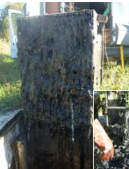
Poste de refoulement de Frasne engorgé par les lingettes
