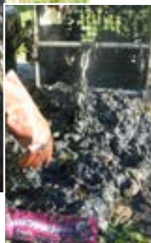
Poste de refoulement de Frasne engorgé par les lingettes
