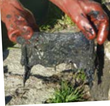
Poste de refoulement de Frasnée = lingettes non dégradées
